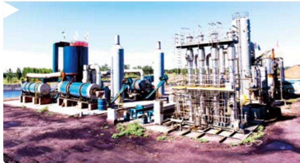
是针对原天津市胜利化工厂遗留污染水土的专业环保治理项目，采用国际先进的热解处理技术和高盐有机废水组合处理技术，通过直接或间接加热，将污染土壤加热至目标污染物的沸点以上，通过控制系统温度和物料停留时间有选择地促使污染物气化挥发，使目标污染物与土壤颗粒分离、去除，实现了苯环类有机污染水土的达标修复治理，为国内有机污染水土修复工程的实施提供了先进的技术与经验，具有示范作用与引领效应，在环境保护、生态修复、资源再利用等方面有很好的社会效益。
